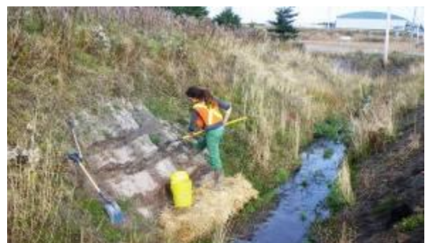
Érection de tranchées dans la paroi afin réduire le ruissellement des sédiments dans le cours d'eau.
