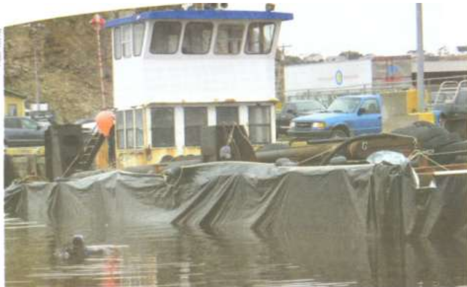
Essai de recouvrement d'une barge au quai de Cap-aux-Meules.
